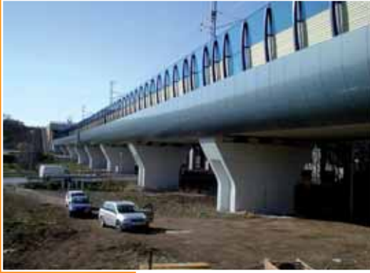
Linea ad Alta Velocità nei pressi di Roma: pannelli antirumore
