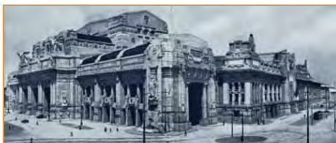
La Stazione Centrale di Milano
